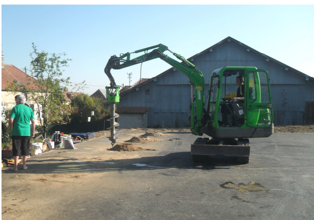
Construction du stade
