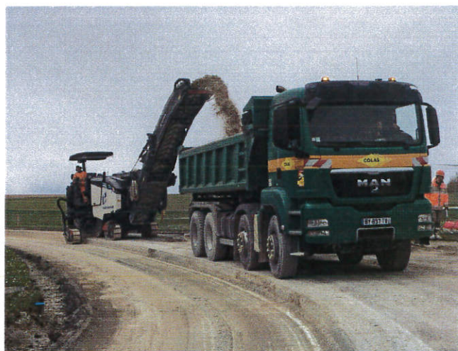
Défonçage de l'enrobé
