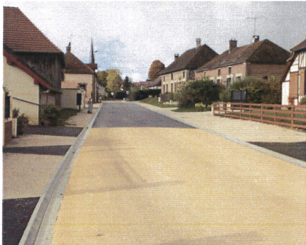
La traversée du village
