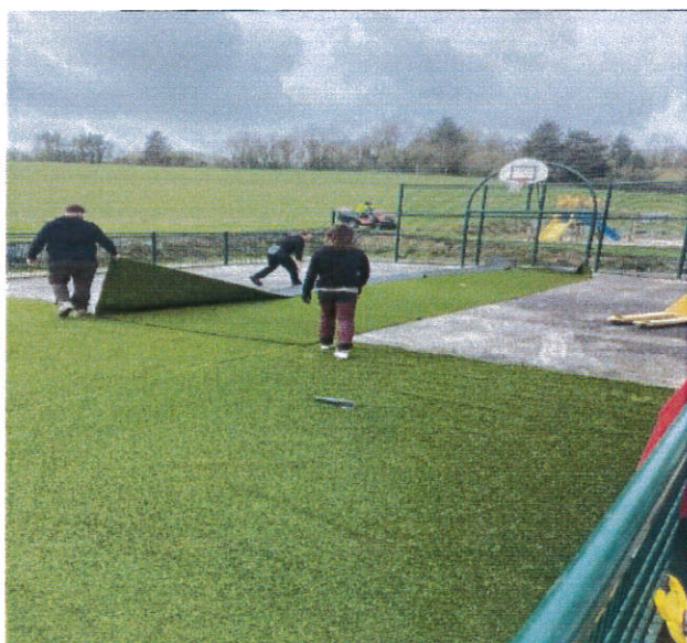
Pose du nouveau revêtement
