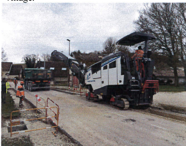
Défonçage des bordures de trottoir
