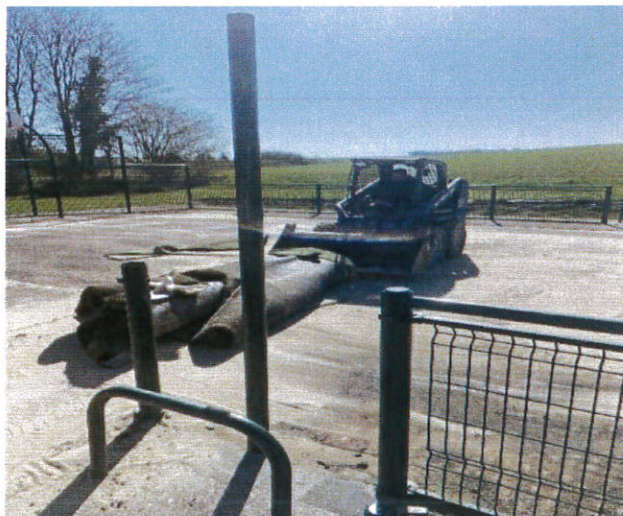
Enlèvement de l'ancien revêtement
