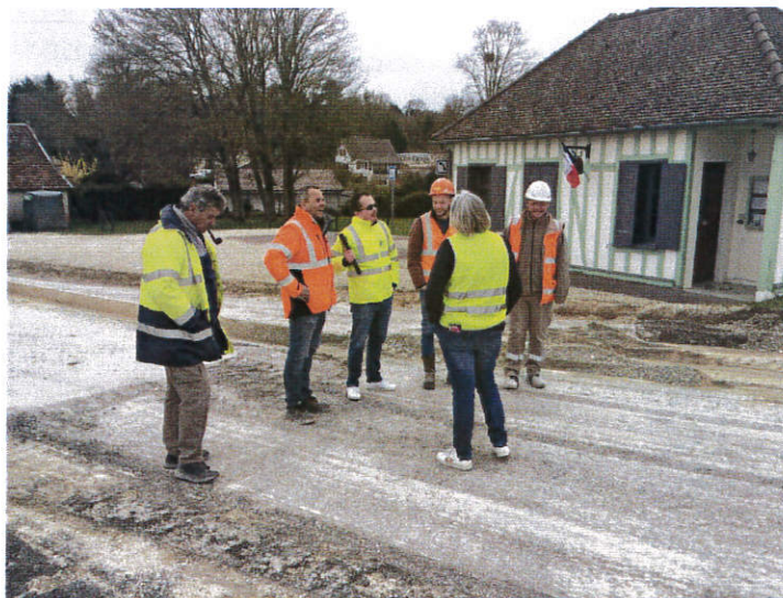
Réunion de chantier hebdomadaire
