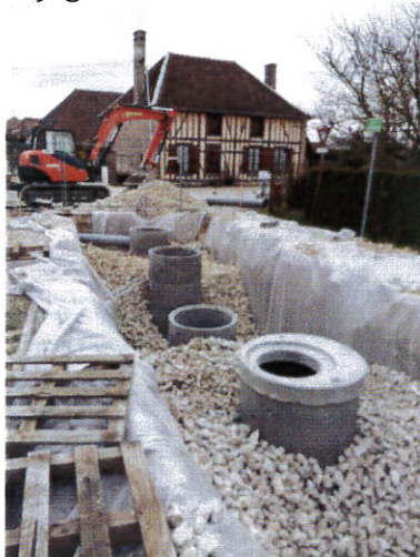
Rénovation de l'écoulement des eaux pluviales
