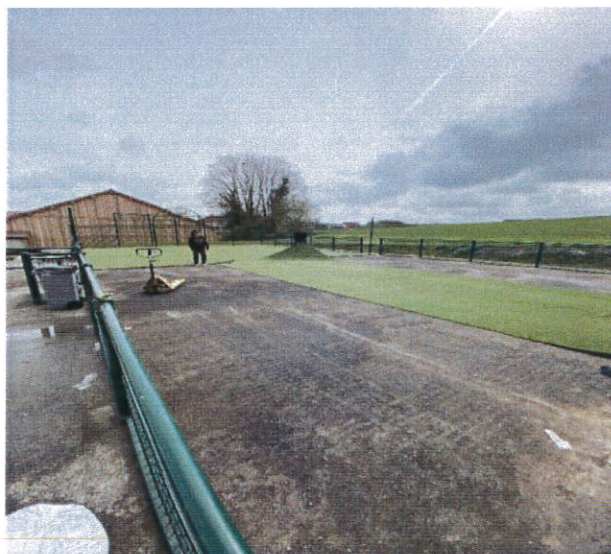
Pose du nouveau revêtement
